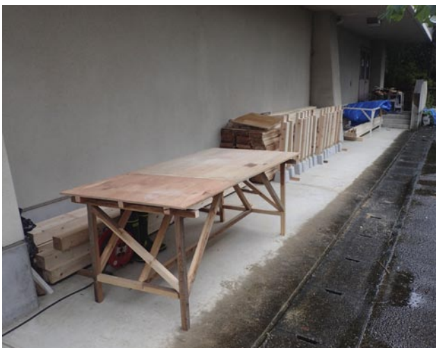
崇仁高瀬川作業所
