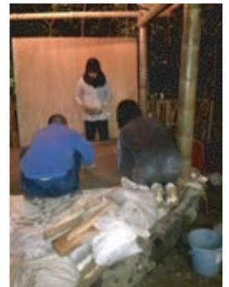
いよいよ床の仕上げにとりかかる。根太の上にコンパネを載せてビスで固定し、その上に三和土の土をたたき、乾いてから化粧土を刷毛で塗る方法で床を仕上げた。
