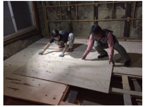
敷居も取って部屋を一続きに。床を安定させないと作業しにくいので2×4材でフレームをつくり、構造用合板を仮張り。
