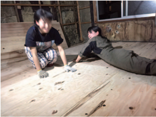
5月18日 仮張りできた床に寝そべる。 安定した床のありがたさを実感。
