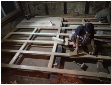
敷居も取って部屋を一続きに。床を安定させないと作業しにくいので2×4材でフレームをつくり、構造用合板を仮張り。
