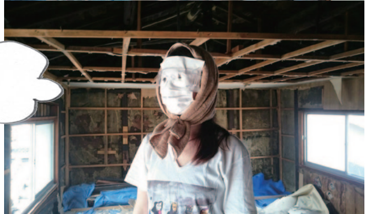
天井板からシートをはがす。次いで吊り構造のフレームを落とす
