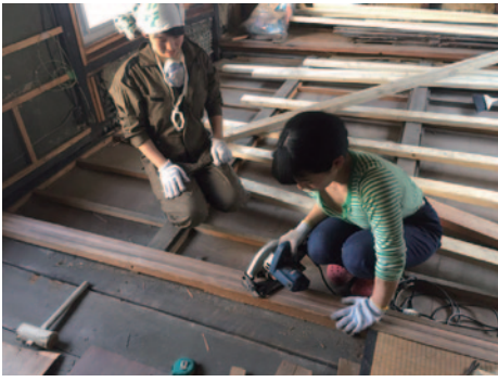
敷居も取って部屋を一続きに。床を安定させないと作業しにくいので2×4材でフレームをつくり、構造用合板を仮張り。
