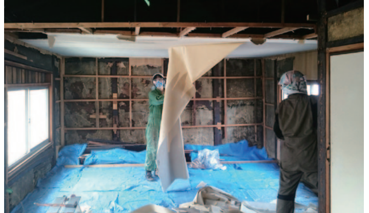
敷居も取って部屋を一続きに。床を安定させないと作業しにくいので2×4材でフレームをつくり、構造用合板を仮張り。
