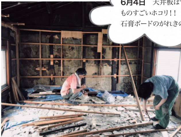
屋根裏の野地板はラフな継ぎはぎ状態。 竹木舞むき出しの土壁は真っ黒だった。
